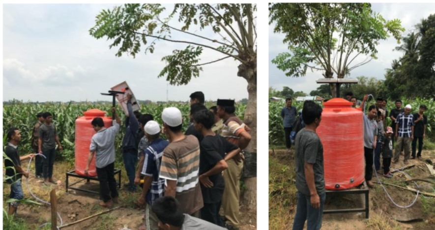
Gambar 7. Pemasangan Pompa Air Tenaga Matahari di Areal Persawahan Petani
